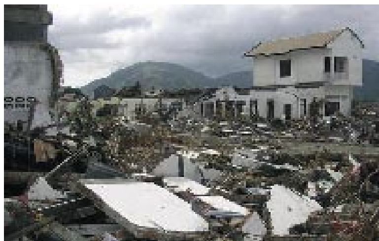
Das zerstörte Gymnasium in Banda Aceh.
